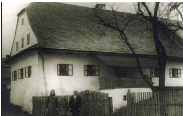
Dům č.p. 5 patří k nejstarším domům v této části obce. Postaven je v letech 1786 a v roce 1916 byla provedena celková oprava domu. Původní dům byl zbourán a na původním místě je postaven nový objekt, který získal i původní číslo domu. Foto pochází z roku 1936. Archiv obce.
