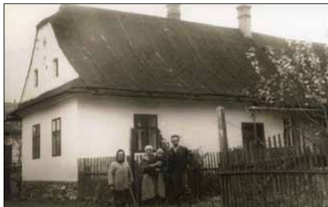
Dům č.p. 8 patří k těm nejstarším domům. Byl postaven v roce 1786 a v roce 1846 byl přestavěn. Poslední oprava domu se uskutečnila v roce 1930. Foto pochází z roku 1936. Archiv obce.
