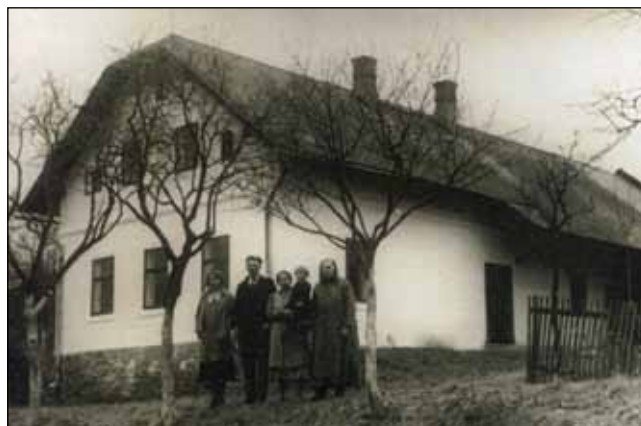
Dům č.p. 7 byl postaven 1786. V roce 1936 byl nově opraven a provedena modernizace hospodářského objektu pro chov dobytka a koní. Foto pochází z roku 1936. Archiv obce.
