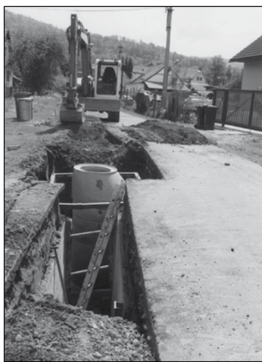
Výstavba kanalizační šachty u čp. 311 dne 23. 5. 2017
