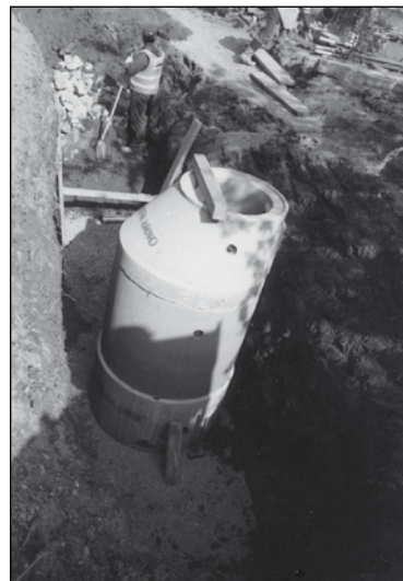
Výstavba kanalizační šachty na břehu Klepáčovského potoka dne 23. 5. 2017
