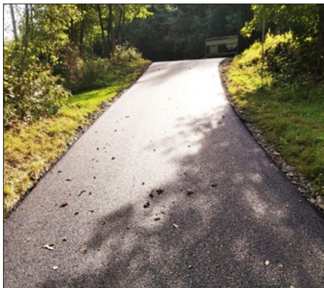
Oprava MK v Rudolticích
