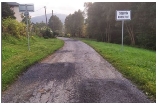
Oprava výtluků na MK v obci
