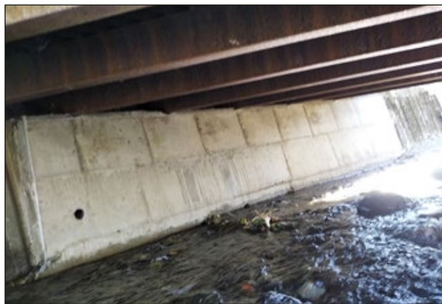
Oprava mostu u Soudků
