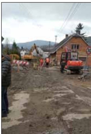
Budování kanalizace u čp. 95
