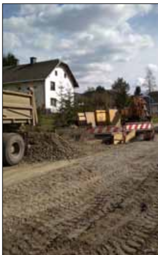
Budování kanalizace u čp. 93
