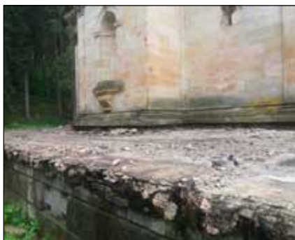
Oprava Mauzolea Kleinů
