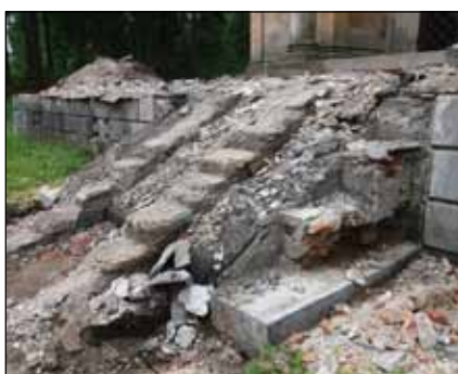
Oprava schodiště Mauzolea Kleinů
