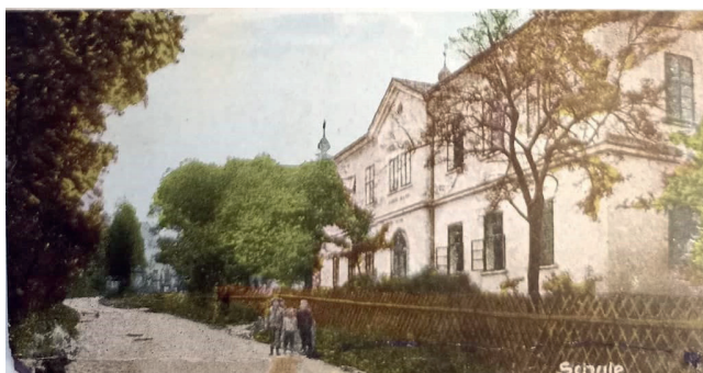
Sobotínská škola na čp. 100. Škola fungovala až do roku 1945, později sloužila pro děti z Řecka a v roce 1953 se přestěhovala do školního areálu. V dnešní době zde sídlí Obecní úřad Sobotín. Archiv autora. Rok 1920.
