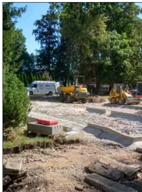
Stavba parkoviště u obecního úřadu
