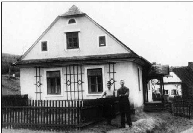
Opěrné mříže pro výsadbu okrasných keřů a růží u čp.136. Dům vyhořel v roce 1945. Foto v roce 1936. Archiv obce.
