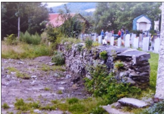
Hřbitovní zeď s márnicí se opravovala v několika etapách (mezi roky 2011 až 2015).
