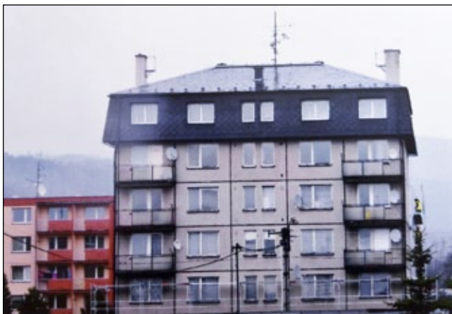
Panelový dům č.p. 220 v Sobotíně byl vybudován v letech 1972–1973, v roce 1998 byla přistavěna nástavba.
