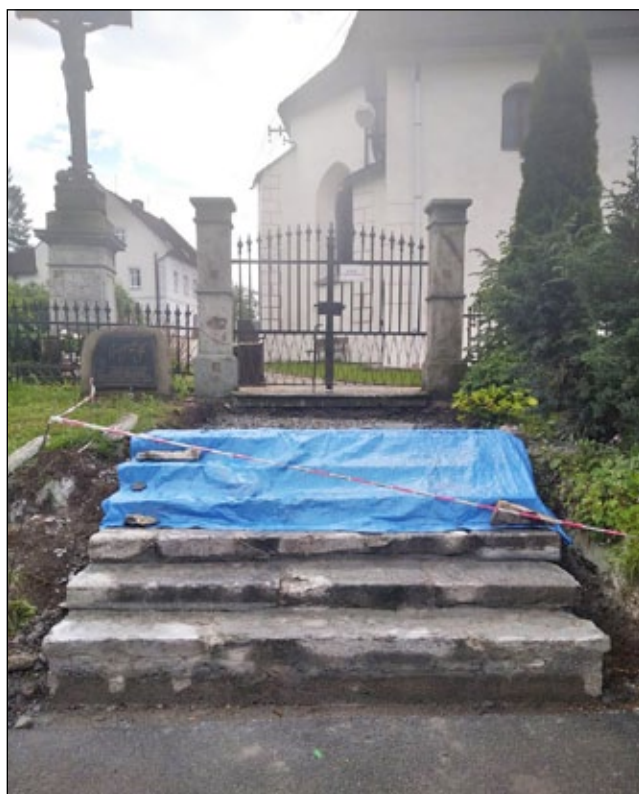
Oprava hřbitovních schodů
