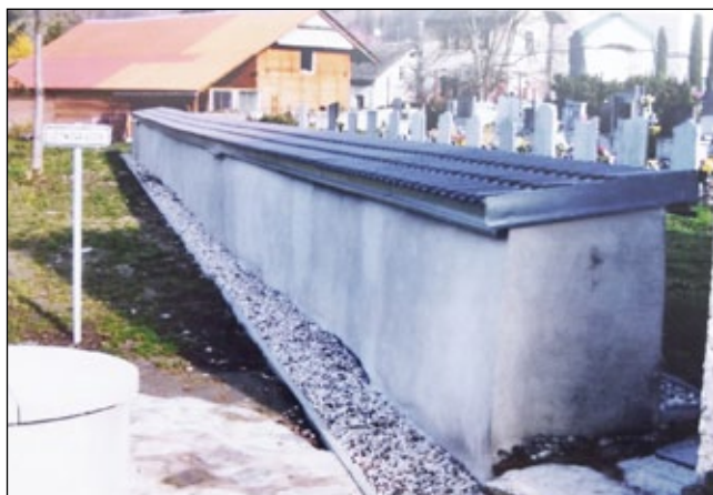
Na snímku je vidět oprava hřbitovní zdi z r. 2013.
